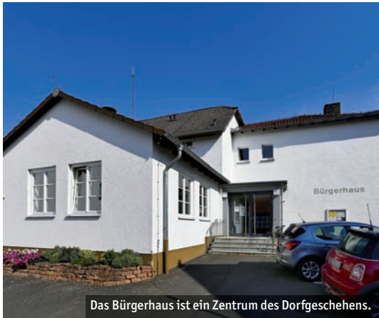
Das Bürgerhaus ist ein Zentrum des Dorfgeschehens.
