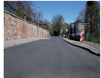
Die Straße Barfußertor ist dank des neuen Fahrbahnbelags fahrradfreundlicher. (Foto: Ingwersen)
