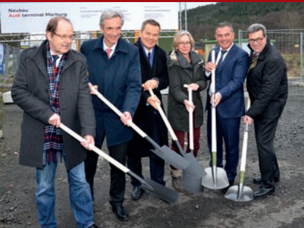
Wirtschaftsstandort stärken: Marburg bekommt ein Audi-Autohaus - Spatenstich in der Afföllerstraße. (Foto: Krause)
