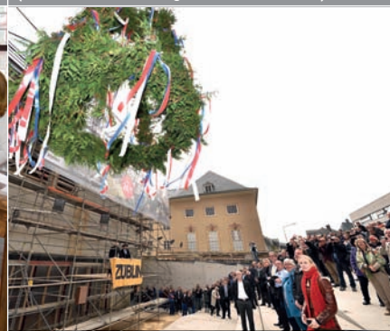
Auch das Wetter machte mit: Richtfest für den Umbau des Erwin-Piscator-Hauses gefeiert. (6.11., Foto: Georg Kronenberg)
