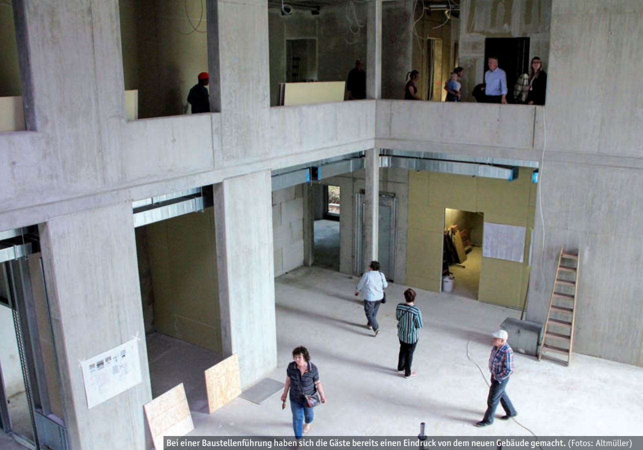
Bei einer Baustellenführung haben sich die Gäste bereits einen Eindruck von dem neuen Gebäude gemacht. (Fotos: Altmüller)
