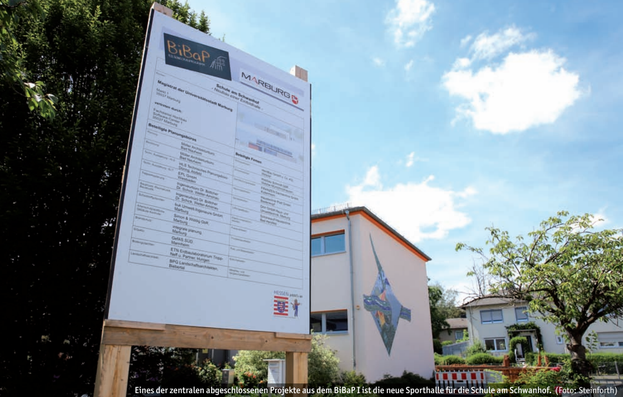
Eines der zentralen abgeschlossenen Projekte aus dem BiBaP I ist die neue Sporthalle für die Schule am Schwanhof. (Foto: Steinforth)
