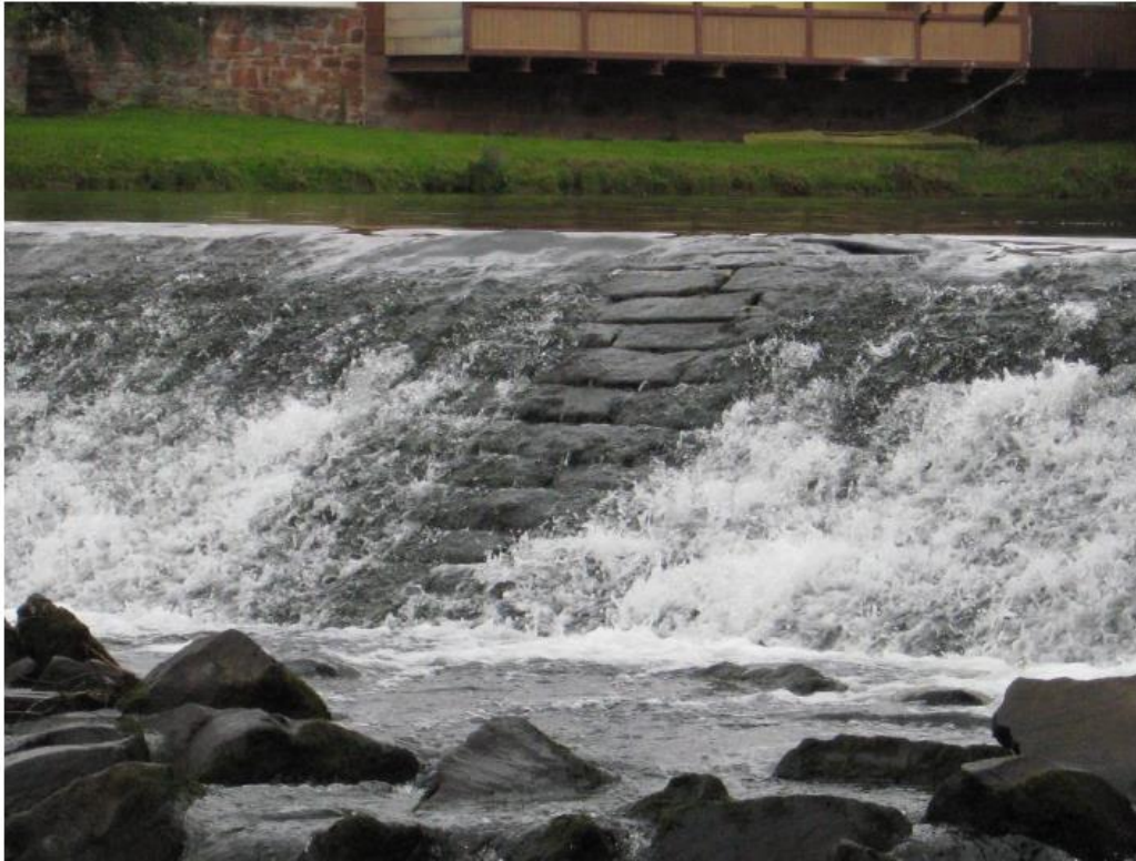
Bild 5: Hochpunkt in der Wehrkrone führt zu Strömungsabriss
