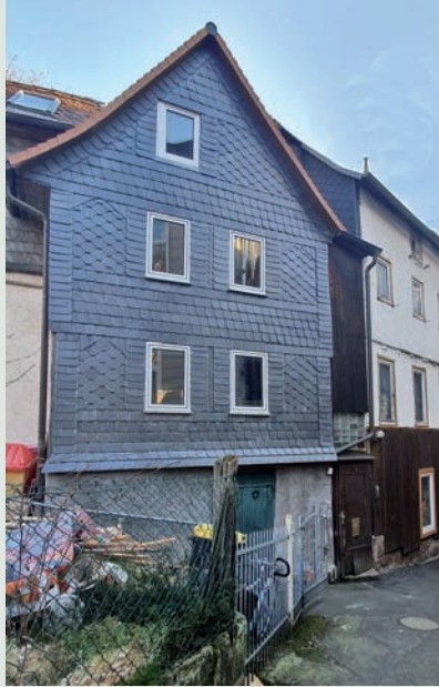
Das verschieferte Gebäude Karmelitergasse 3 ist ein Fachwerkbau, der aufgrund seines Erscheinungsbildes ohne Geschossauskragungen und mit steilem Satteldach mit Aufschieblingen sowohl aus dem 15. Jahrhun-
