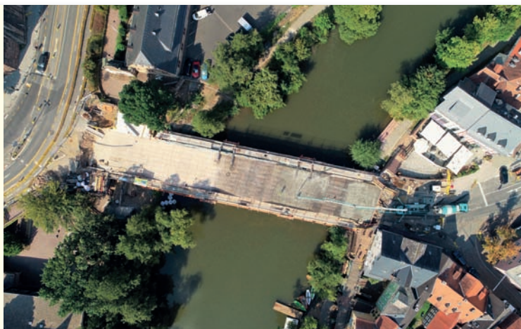
Drei Bögen, drei Arbeitsstadien zeitgleich: Während am ersten Bogen der erste Beton eingebracht wird, laufen die Stahlarbeiten am zweiten Bogen, der dritte Bogen lag noch blank, als die Drohnenaufnahmen im September gemacht wurden. (Foto: EverMania)
