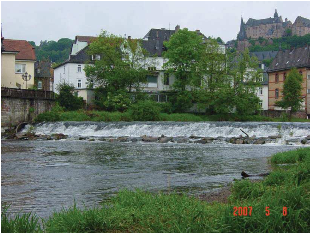
Abbildung 1: Ansicht Grüner Wehr vom linken Lahnufer
