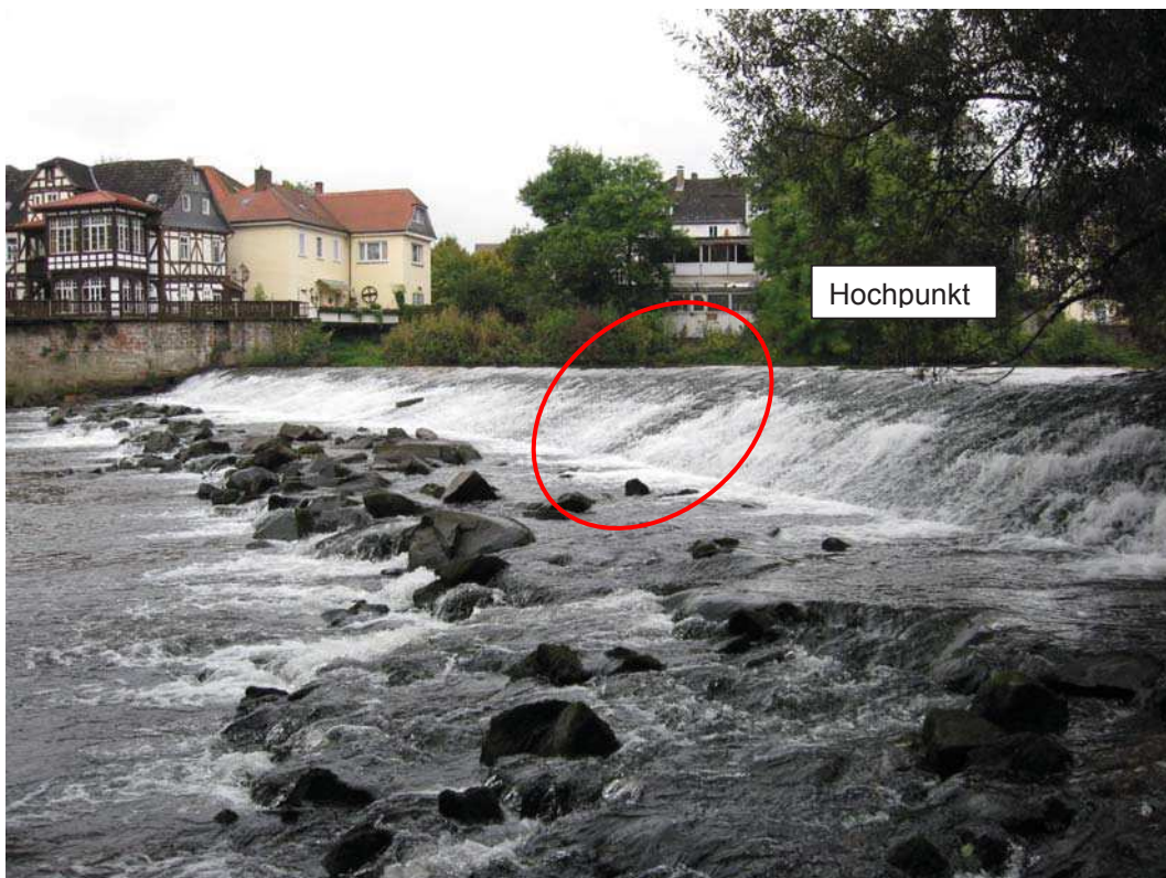
Abbildung 16: Ansicht Wehrfuß in Richtung Ölmühle vom linken Lahnufer
