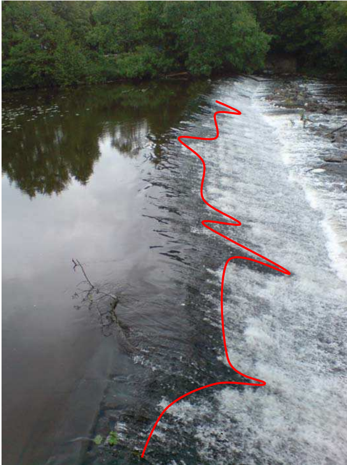
Abbildung 5: Gesamtansicht Wehrkrone von der Ölmühle am rechten Lahnufer
