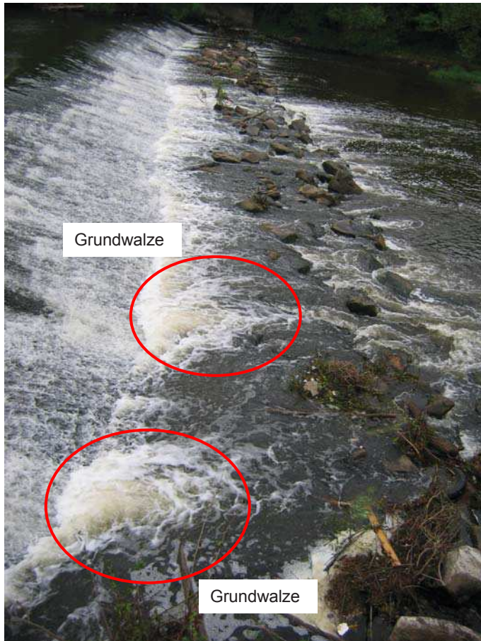
Bild 8: Ausolkungen am Wehrfuß vor der Ölmühle am rechten Lahnufer
