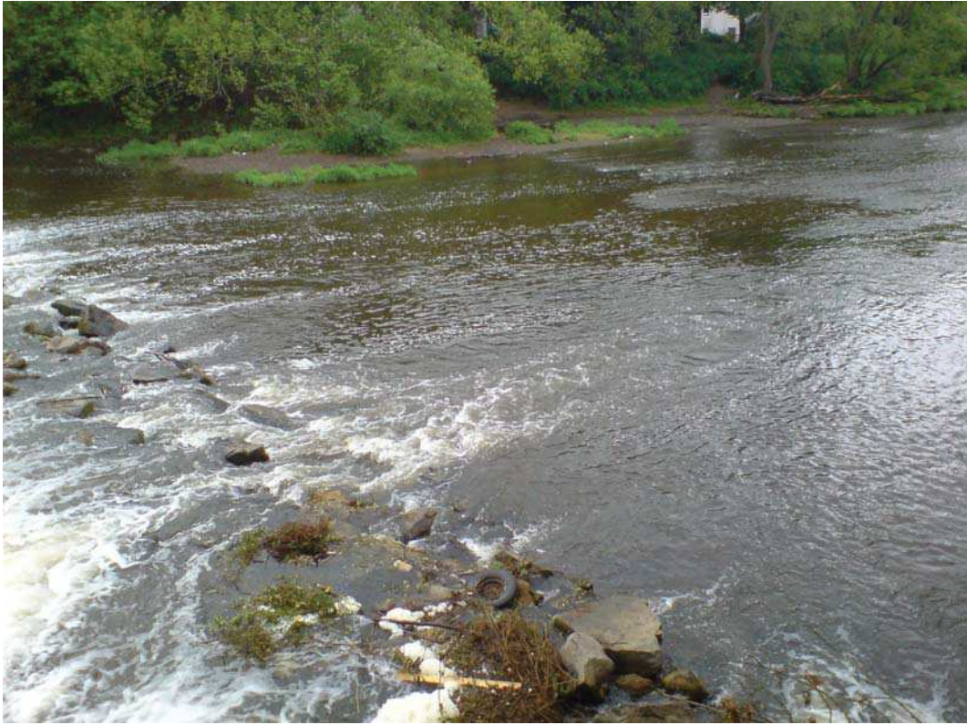
Abbildung 13: Wehrfuß mit Sicherung
