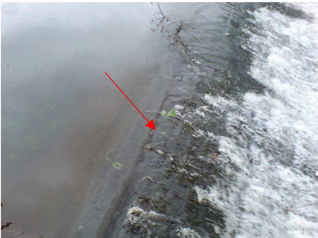
Abbildung 10: Fugen des oberwasserseitigen Deckwerks und Wehrkrone
