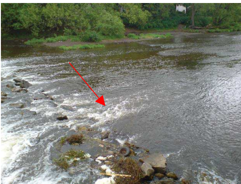
Bild 7: Wehrfuß mit Sicherung
