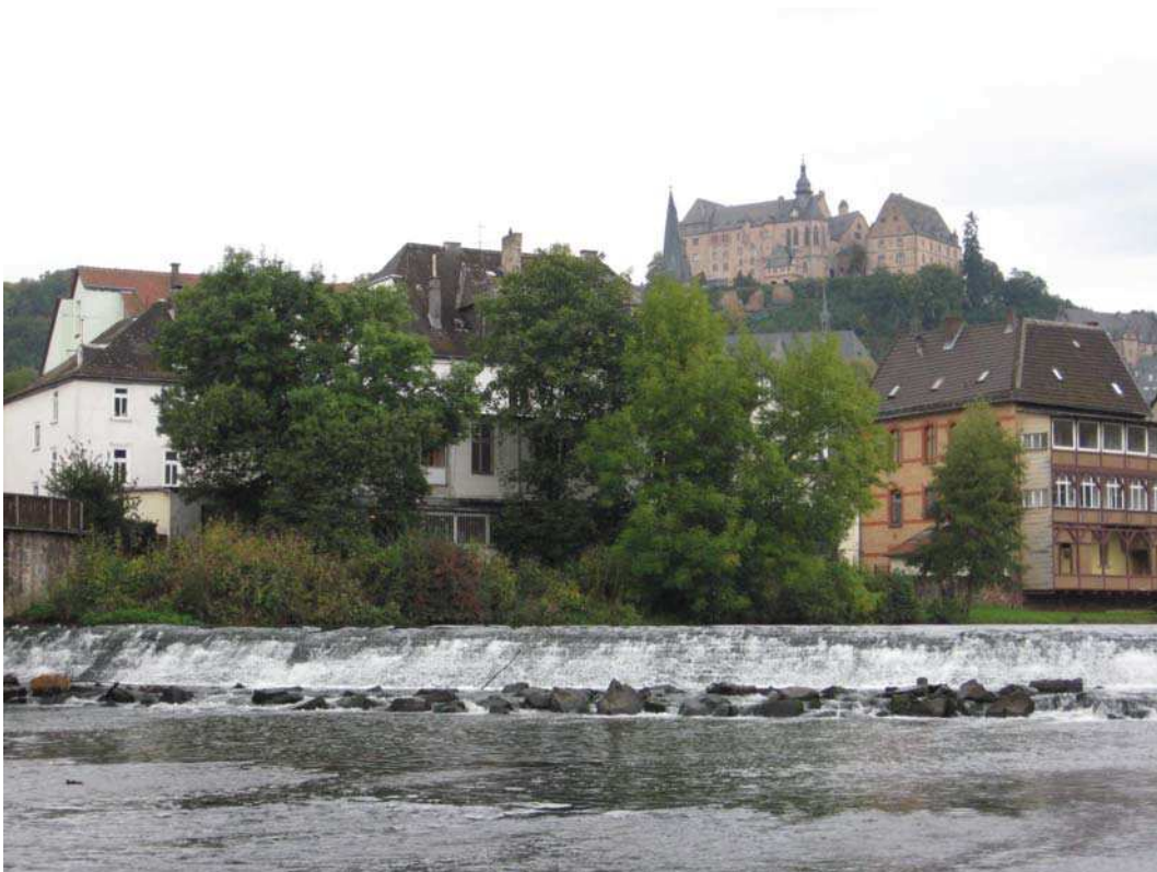
Abbildung 2: Ansicht Unterwasserseite Grüner Wehr vom linken Lahnufer
