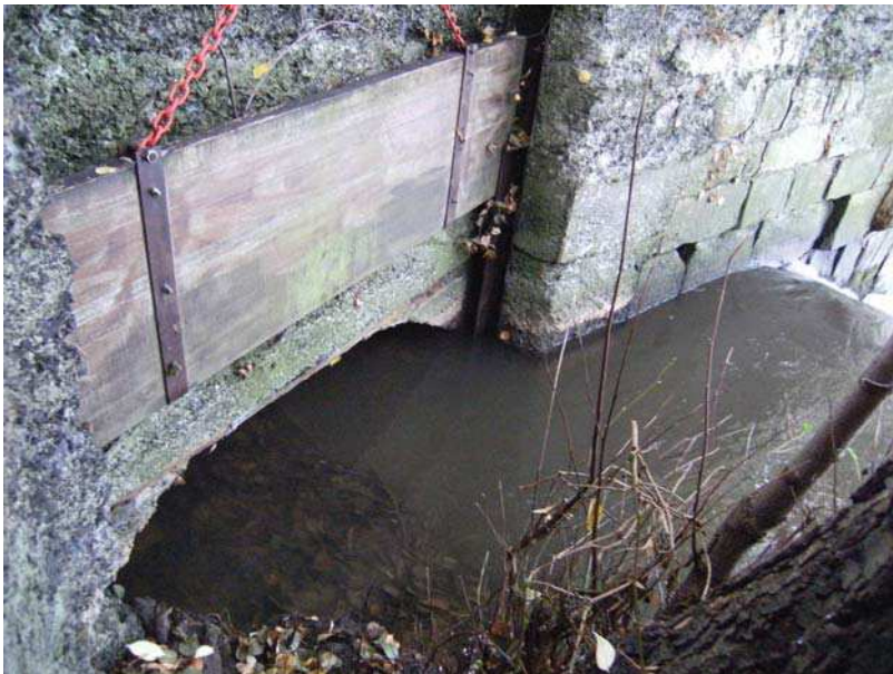
Bild 13: Einlaufbauwerk Hirsemühle im Oberwasser am linken Lahnufer
