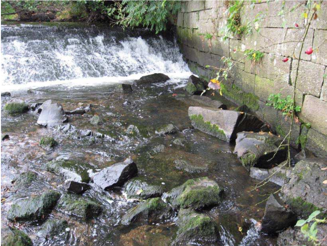
Abbildung 21: Wehrfuß im Bereich der Stützmauer am linken Lahnufer
