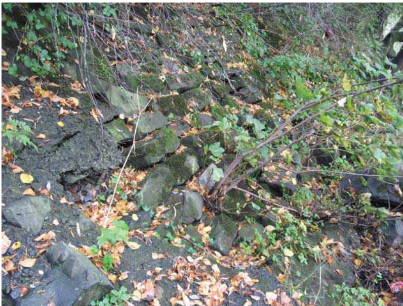
Bild 11: Bruchsteinuferbefestigung am linken Lahnufer
