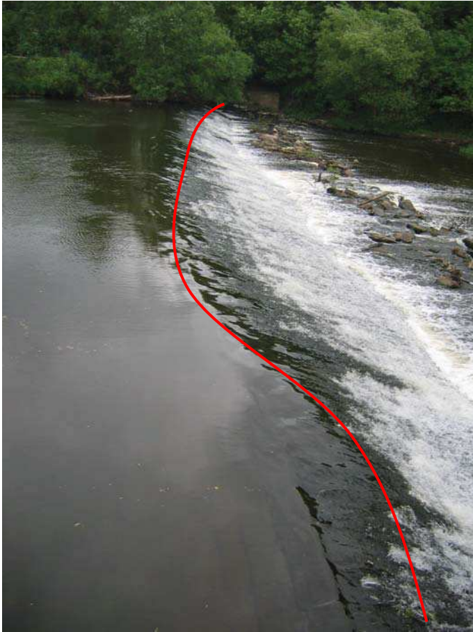
Abbildung 7: Gesamtansicht Wehrkrone von der Ölmühle am rechten Lahnufer
