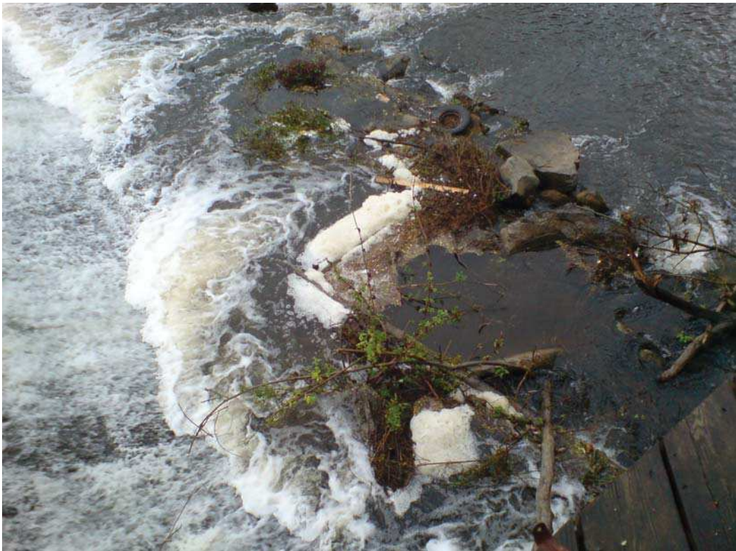
Abbildung 14: Unrat und Treibgut am Wehrfuß vor der Ölmühle am rechten Lahnufer
