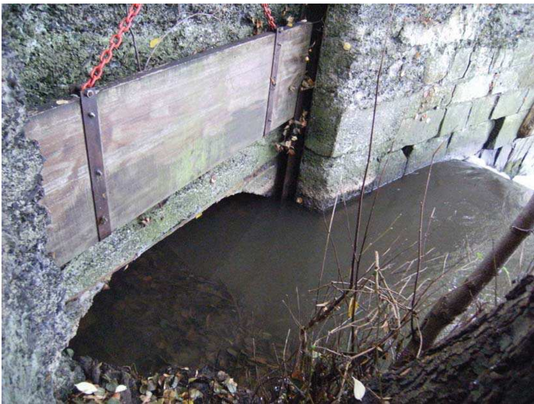
Abbildung 24: Einlaufbauwerk Hirsemühle im Oberwasser am linken Lahnufer
