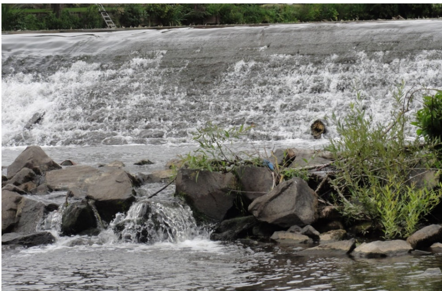
Abbildung 14: Sturzbettsicherung aus Wasserbausteinen
