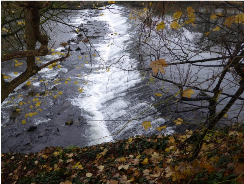
Abbildung 15: Geschwungener Verlauf der Wehrkrone
