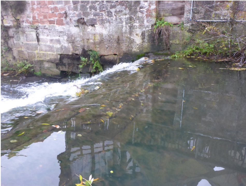
Abbildung 17: Ufer-/Stützmauer rechtes Ufer
