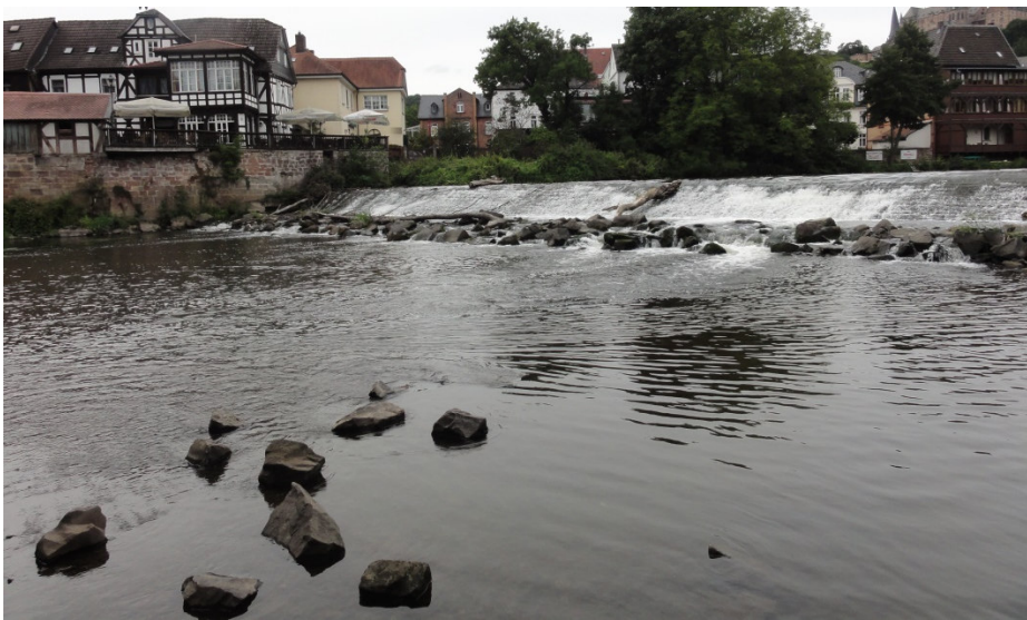
Abbildung 12: Wehr am rechten Ufer
