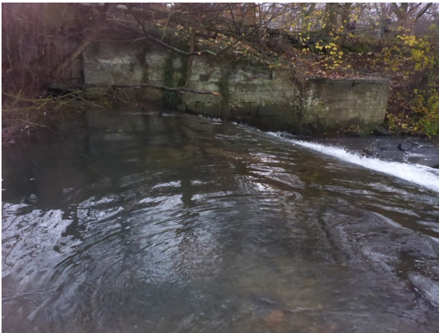
Abbildung 16: Ufer-/Stützmauer linkes Ufer
