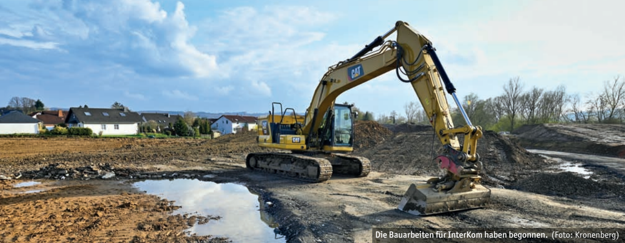
Die Bauarbeiten für InterKom haben begonnen. (Foto: Kronenberg)
