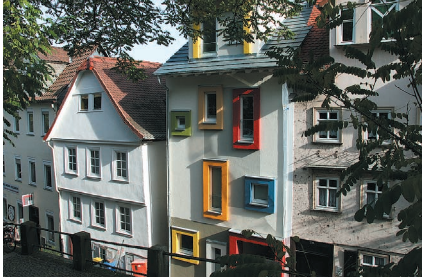
Funktional und optisch ist der Neubau Steinweg 21 mit Passage zum Pilgrimstein eine Bereicherung geworden.
