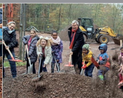
Zusammen mit Kindern aus dem Waldtal setzte OB Spies den ersten Spatenstich für den Bolzplatz Fuchspass. (Foto: Grähling)
