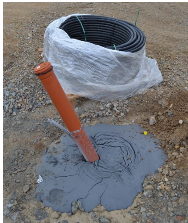
Abb. 9: Verpresste Sondenbohrung.
