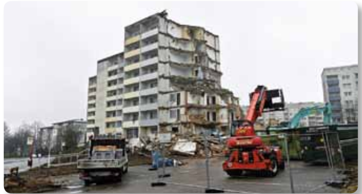
Das bisherige Wohnheim der Altenhilfe St. Jakob am Richtsberg wurde entkernt und das siebenstöckige Gebäude abgerissen. (Foto: Georg Kronenberg, i.A.d. Stadt Marburg)
