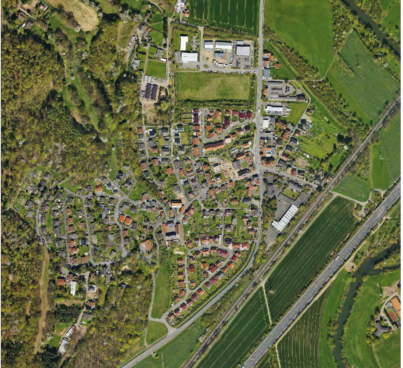
Luftbild des Untersuchortes (Quelle: FD 60_61)
