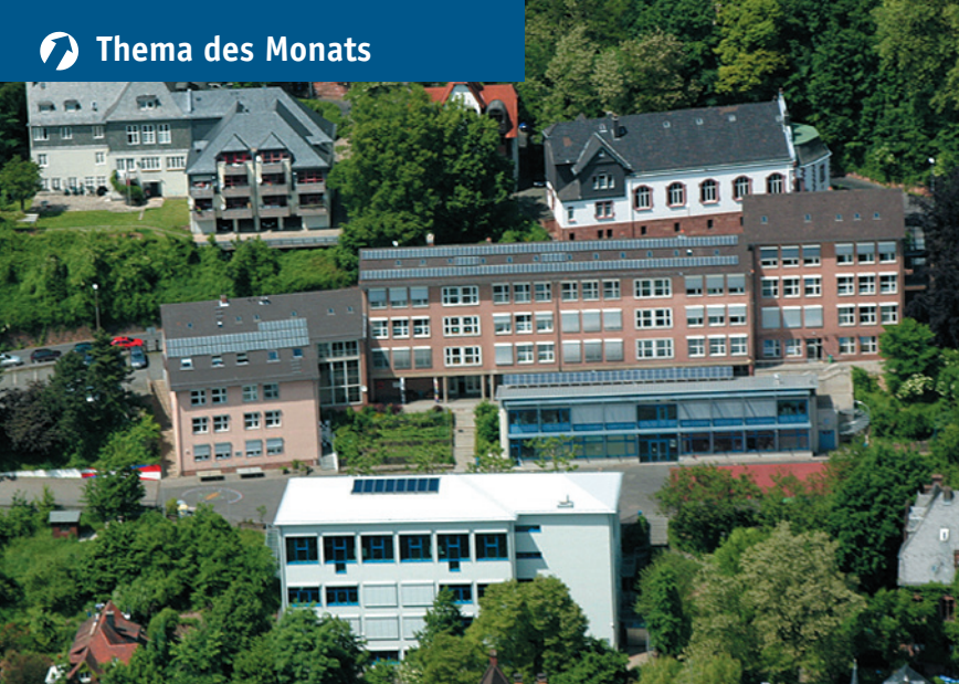
Eine aufwändige Sanierung des Hauptgebäudes der Emil-Von-Behring-Schule (in der Mitte der hinteren Reihe auf dem Luftfoto) steht an
