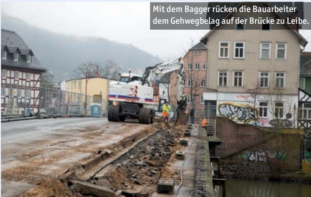
Mit dem Bagger rücken die Bauarbeiter dem Gehwegbelag auf der Brücke zu Leibe.
