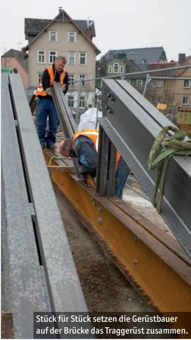
Stück für Stück setzen die Gerüstbauer auf der Brücke das Traggerüst zusammen.
