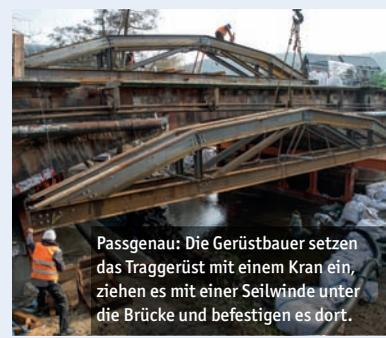
Passgenau: Die Gerüstbauer setzen das Traggerüst mit einem Kran ein, ziehen es mit einer Seilwinde unter die Brücke und befestigen es dort.
