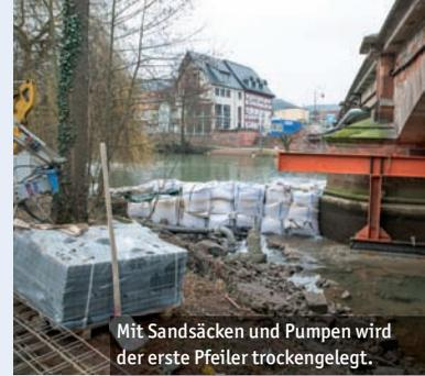
Mit Sandsäcken und Pumpen wird der erste Pfeiler trockengelegt.
