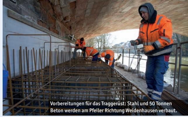
Vorbereitungen für das Traggerüst: Stahl und 50 Tonnen Beton werden am Pfeiler Richtung Weidenhausen verbaut.
