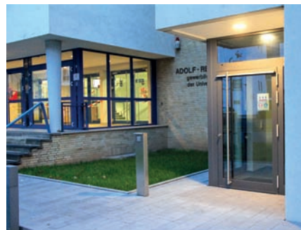
Der neue Aufzug ist direkt neben dem Haupteingang der (Foto: Altmüller)
