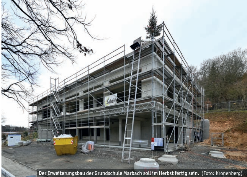
Der Erweiterungsbau der Grundschule Marbach soll im Herbst fertig sein. (Foto: Kronenberg)
