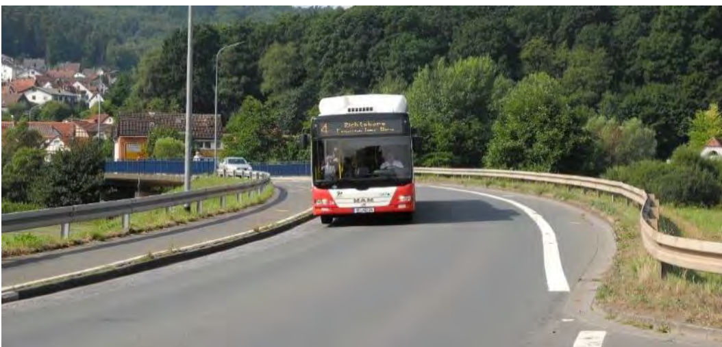
Abbildung 101: Cölber Straße, Lahnbrücke, Blickrichtung Westen
