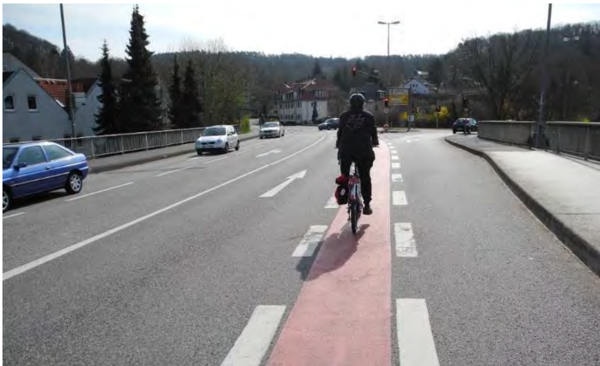
Abbildung 119: Kurt-Schumacher-Brücke, Blickrichtung: Lahnberge (18.04.2013)
