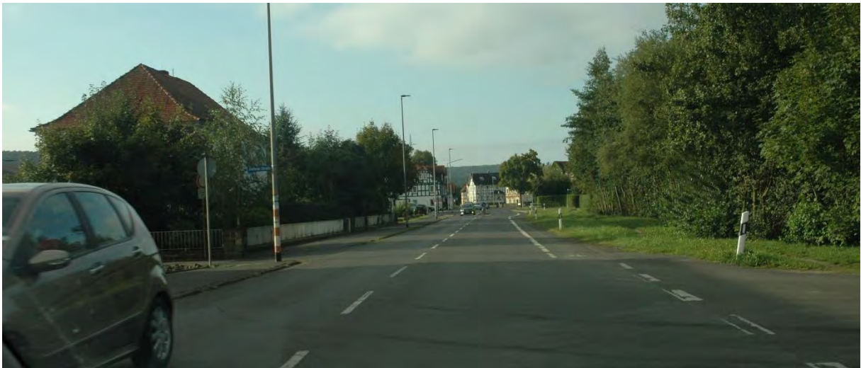
Abbildung 81: Ortseinfahrt Gisselberg (K42, Blickrichtung Süden)
