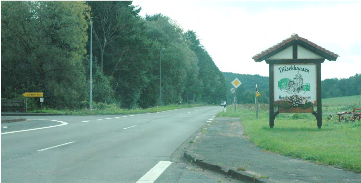
Abbildung 76: Dilschhausen (Blickrichtung Einhausen, K72)
