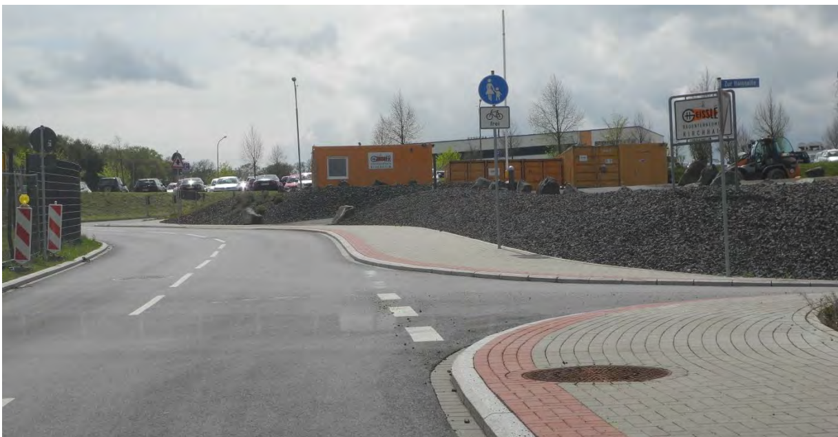
Abbildung 88: Görzhäuser Weg (Blickrichtung Süden)
