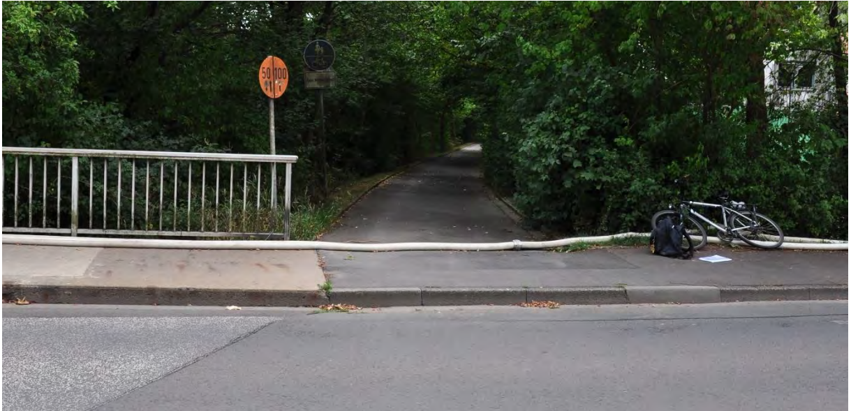
Abbildung 54: L3289 Überführung, In der Badestube (Blickrichtung Süden) 28
