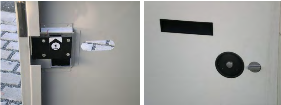
Abbildung 169: Fahrradboxen mit elektronischen Zahlenschloss und Stromanschluss
