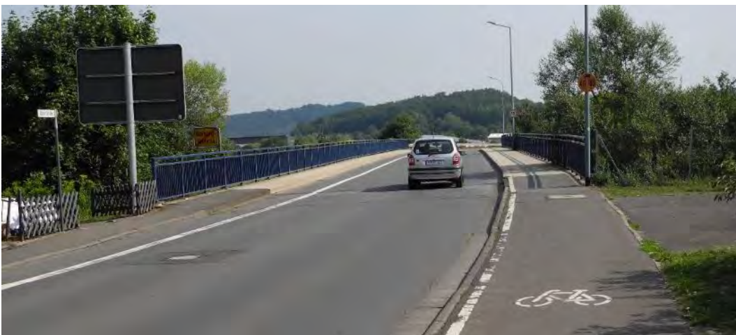
Abbildung 100: Cölber Straße (K82), Lahnbrücke, Blickrichtung Osten
