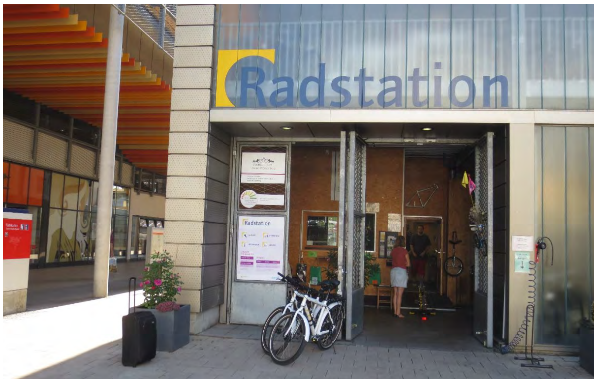
Abbildung 173: Beispiel für eine Fahrradstation mit umfassendem Service (Parken, Reparatur, Verleih usw.): Bahnhof Stadt Ludwigsburg
