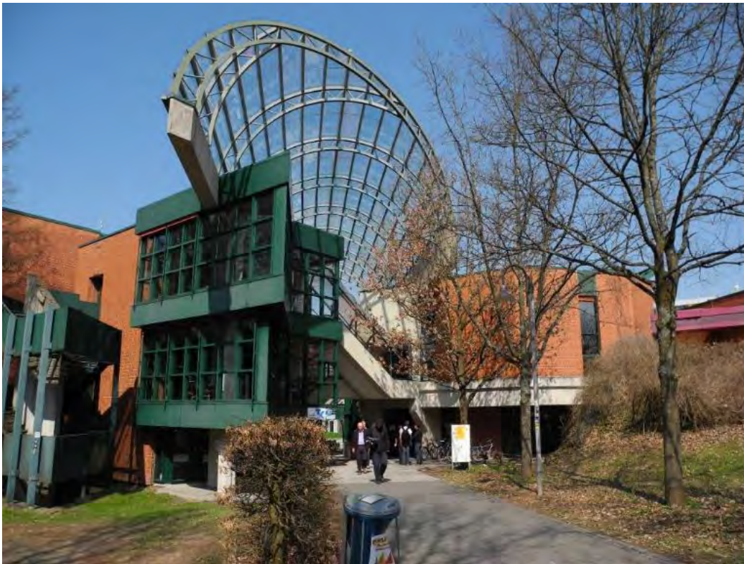
Abbildung 133: Anschluss an einen Gehweg zur Mensa Lahnberge, Blickrichtung: Nord-West (18.04.2013)
