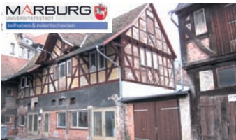
„Die denkmalgeschützten Remisen werden bis 2015 konstruktiv und energetisch saniert und sollen als Leuchtturmprojekt dienen.“
