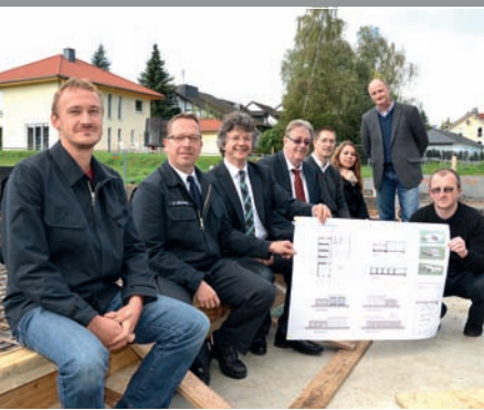
Baubeginn in Bauerbach: Fundament für Feuerwehrhaus im Stadtteil gelegt. (23.9., Foto: Ute Schneidewindt)
