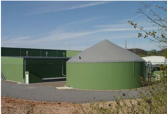
Abbildung 16: Biogasanlage Cyriaxweimar; Quelle: Stadtwerke Marburg, Karin Brahms
