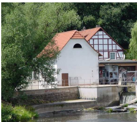
Abbildung 19: Wasserwerk Wehrda; Quelle: Stadtwerke Marburg
