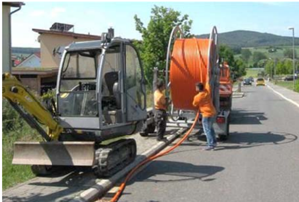
Abb.43: Glasfaserkabelverlegung in Michelbach (links) und Spatenstich zum Glasfaserausbau in Einhausen 2015 (rechts) Quellen: www.op-marburg.de (2014) / www.stadtwerke-marburg.de (2016).
