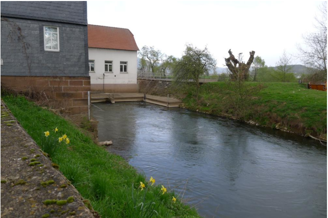
Abbildung 70: Wasserkraftanlage in Marburg
