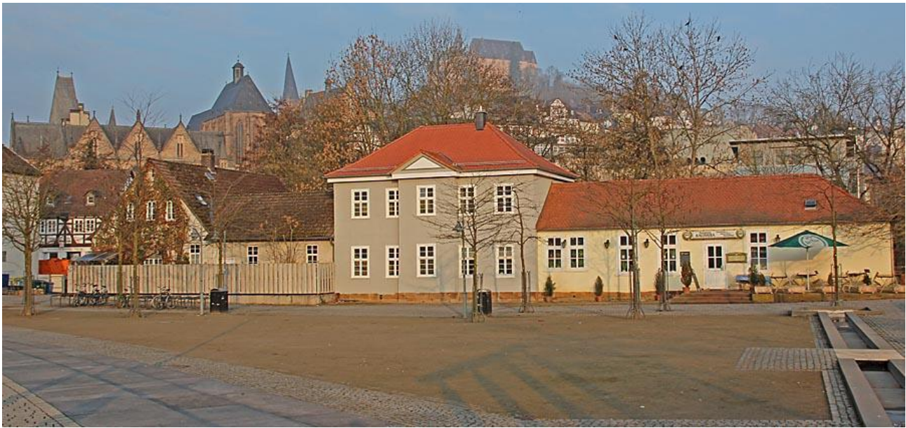
Abbildung 32: Vorbildliche Energetische Modernisierung des eines Kulturdenkmals: Die „Alte Zootomie“ (Foto: Rainer Kieselbach)
