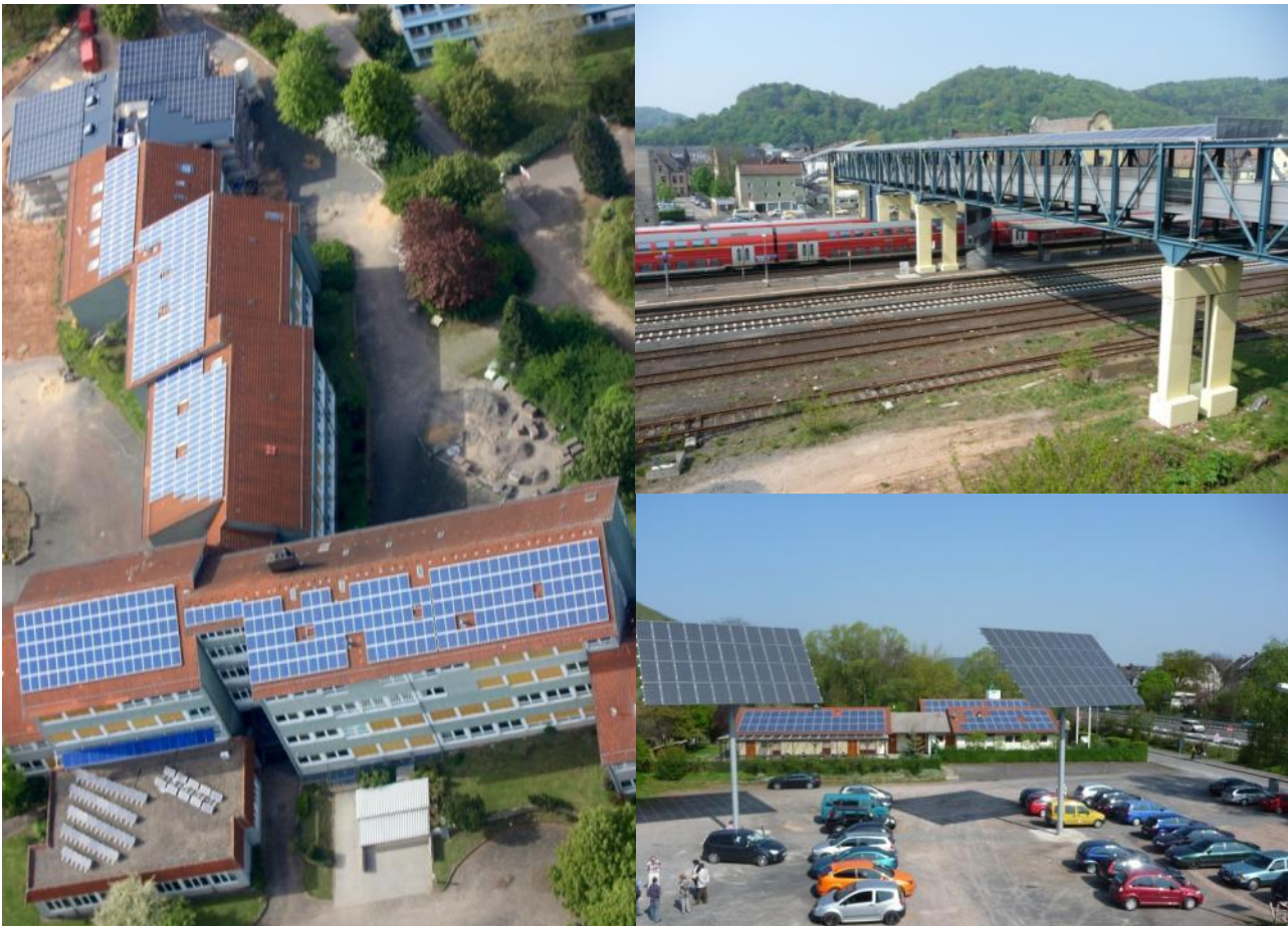
Abbildung 29: Photovoltaikanlagen auf öffentlichen Gebäuden, Freiflächenanlagen sowie am Bahnhof Marburg (Quelle: Universitätsstadt Marburg)
