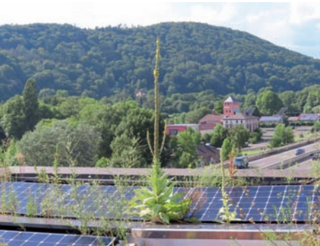
Immer mehr Photovoltaikanlagen auf Marburgs Dächern. (Foto: Kopp)
