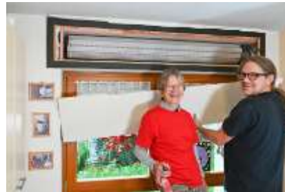
Rolladenkasten dämmen
