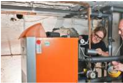
Heizungsrohre dämmen
