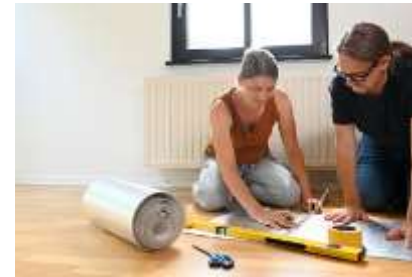
Heizungsnische dämmen
