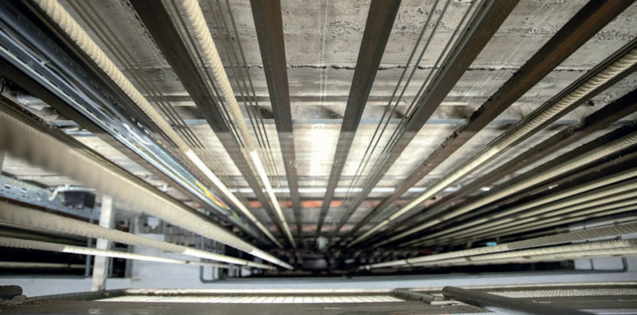
Drahtseilakt: An Drähten und Tauen hängen die Kulissen im Bühnenbereich. (Fotos: Grähling)
