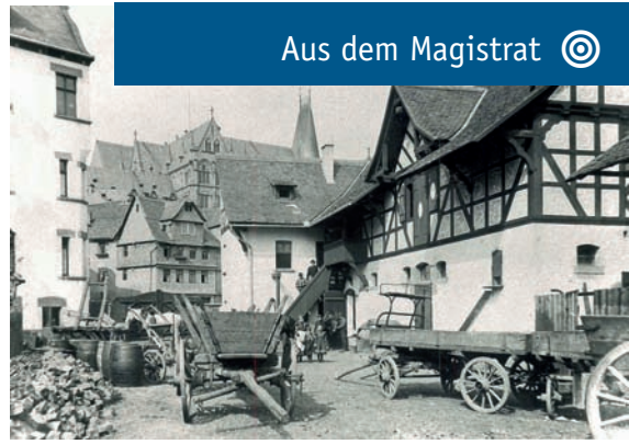
Nach einer grundlegenden Sanierung wird in diese ehemaligen Remisen des Fronhofs schulisches Leben einziehen.
