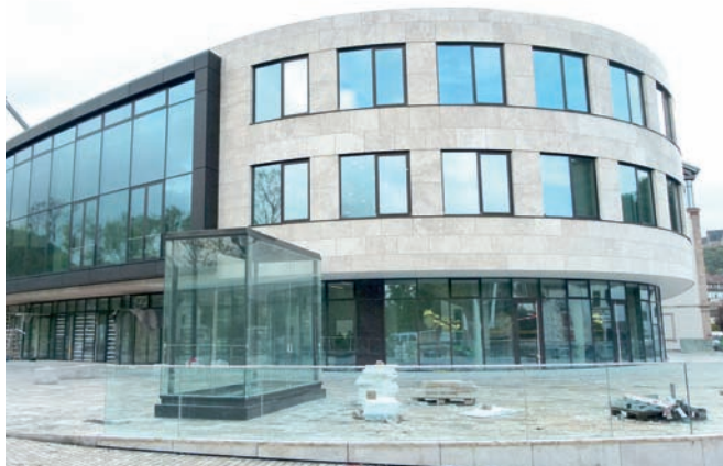
Marburgs Großbaustelle im Norden, das DVAG-Zentrum, geht der Vollendung entgegen.
