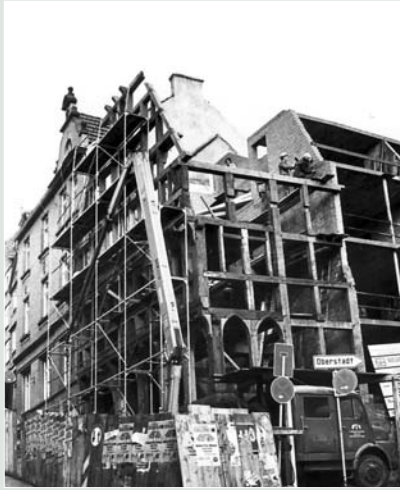
Notwendige Kombination aus restauriertem Fachwerk und Massivbauweise.
