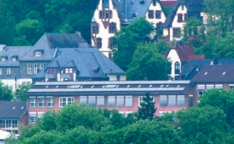
Das Dach der Emil-von-Behring-Schule verdeutlicht, dass Photovoltaik-Module auch im sensiblen Altstadtbereich möglich sind.
