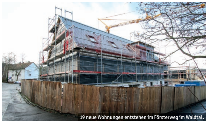
19 neue Wohnungen entstehen im Försterweg im Waldtal.
