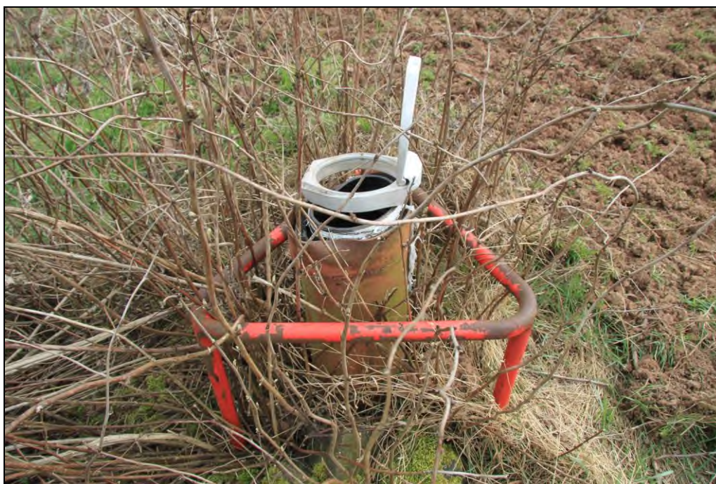
Bild 3: GWM 3 mit deformierter Rohroberkante und aufliegender Seba-Kappe, Blickrichtung Südosten
