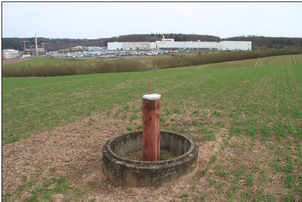
Bild 1: GWM 1 mit dem Gewerbepark Görzhäuser Hof im Hintergrund, Blickrichtung Südosten
