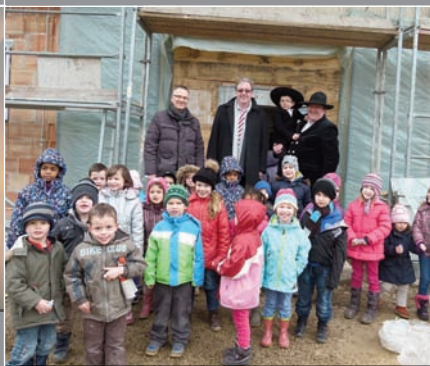
Richtfest Kita und Familienzentrum Gerhart-Hauptmann-Straße (19.3.2013, Foto: Ute Schneidewindt)
