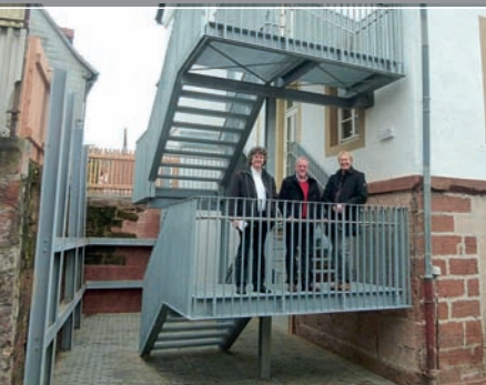
Brandschutztechnische Sanierungsmaßnahmen am Gemeinschaftshaus „Alte Schule“ Ockershausen (09.12.2013, Foto: Tina Eppler)
