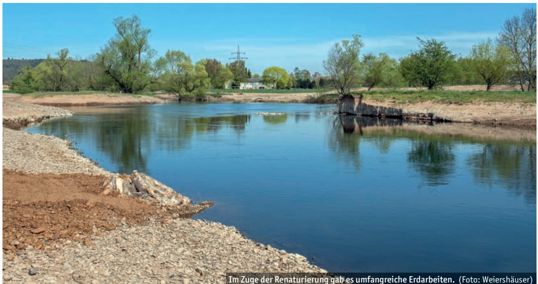
Im Zuge der Renaturierung gab es umfangreiche Erdarbeiten. (Foto: Weiershäuser)
